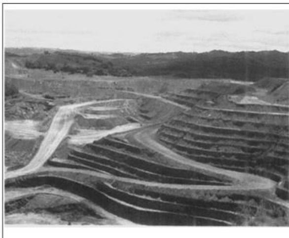
A. EXPLOITATION À CIEL OUVERT
